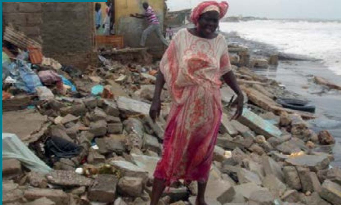
Maisons touchées par l'érosion côtière Crédit : LSD
